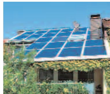
Installation Premium placée sur la totalité du toit ; 22 modules, avec intégration d'une lucarne.
