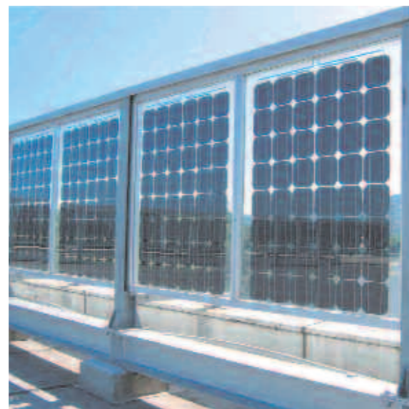
Module PV double face, intégré dans une balustrade isolée.
