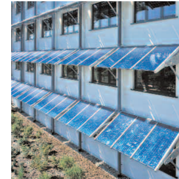
234 modules sans cadre avec un rendement total de 45 kWp, construction spéciale en auvent.
